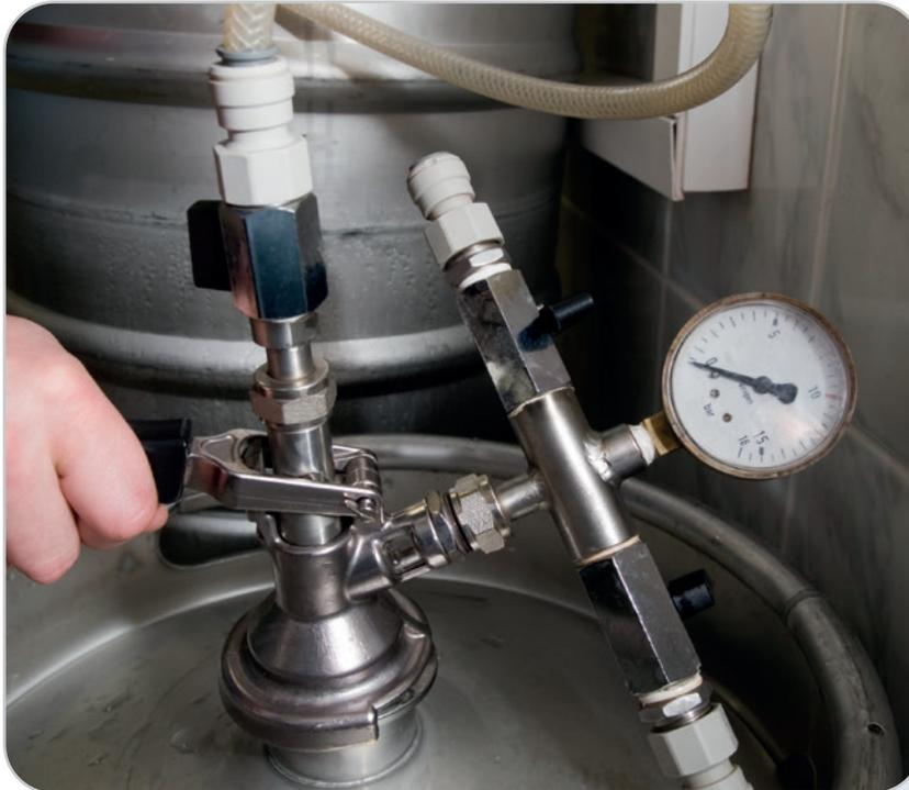
La costruzione di sistemi di distribuzione di birra è soggetta a rigide specifiche tecniche e requisiti di prestazione. I manometri sono utilizzati insieme ai regolatori per controllare la portata del gas che spinge la birra, cioè una miscela di CO<sub>2</sub> e N<sub>2</sub>.
